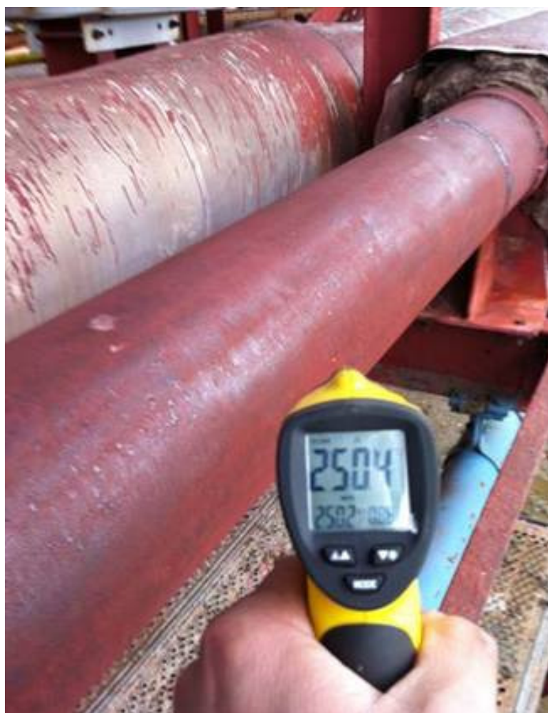
Rysunek nr 1. Pomiar temperatury na nieizolowanym rurociągu
